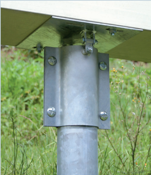
Bewegliche Kopfplatte in 3 Richtungen verstellbar
